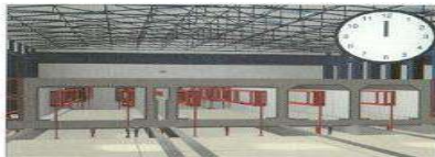
Sedan byggs formen och fylls kontinuerligt med betong. Varje segment tar 24 timmar att gjuta. Betongen härdar i 72 timmar. Åtta segment bildar ett 178 meter långt element.
